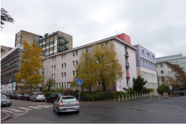
Abb.6: Blick von Kreuzung Gräfstr./Mertonstr.
