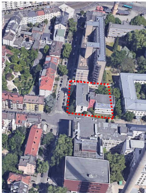
Abb.3: Blick von Süden Foto: Google Maps, 2019
