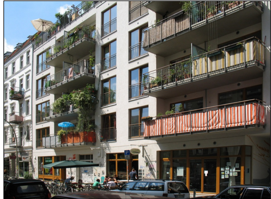
Beispiel Markthof, nachbarschaftliche Hilfe im Karolinenviertel Marktstraße 102, 16 Wohnungen, davon 2 rollstuhlgerechte Wohnungen. Architekten: überNormalnull und Planungsbüro Deichstraße
