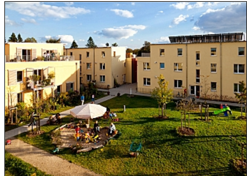
Kleine Horst - Klimaschutzsiedlung - Hamburg Nord, Klein Borstel Sodenkamp 11 - 17
